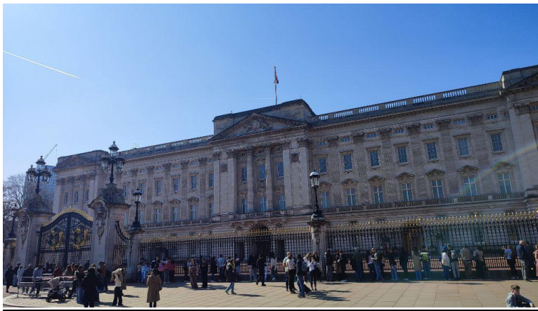
Der Buckingham Palace mit der Flagge auf dem Dach
