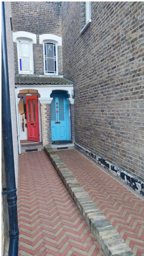
Die beiden Hauseingänge
